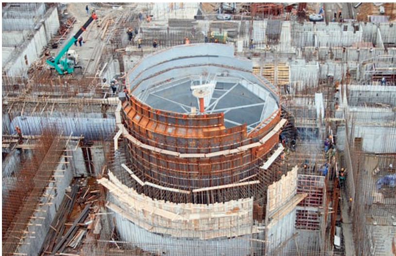
Стройплощадка энергоблока с реактором БН-800 (Белоярская АЭС)
