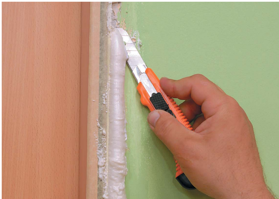
Рис. 26. Удаление излишков затвердевшей пены
