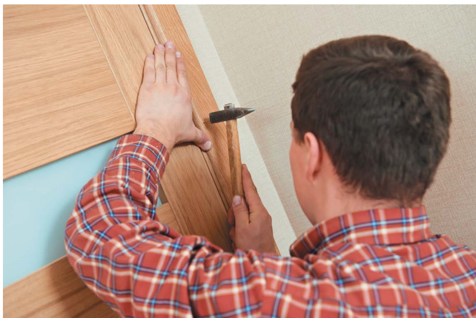
Рис. 27. Установка наличников
