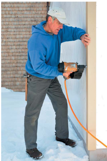
Рис. 42. Крепление углового элемента
