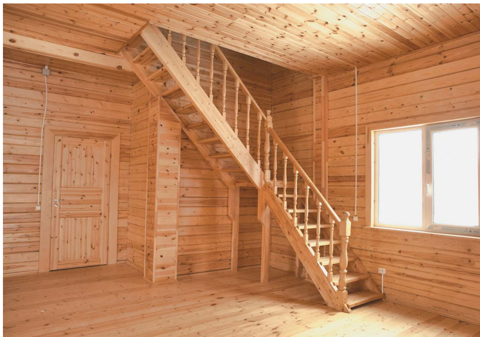
Рис. 28. Деревянная лестница в доме из бруса
