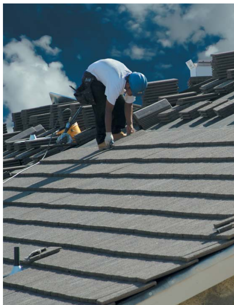
Рис. 18. Укладка кровли из керамической черепицы
