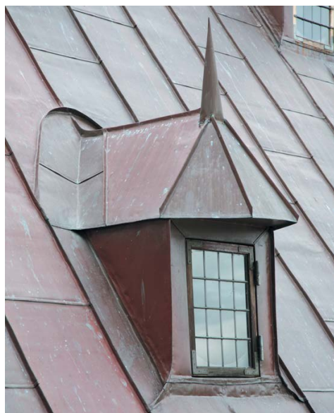
Рис. 19. Сегодня медная кровля — большая роскошь. Это вечный материал, внешний вид которого с годами несколько теряется, но по эксплуатационным характеристикам только выигрывает
