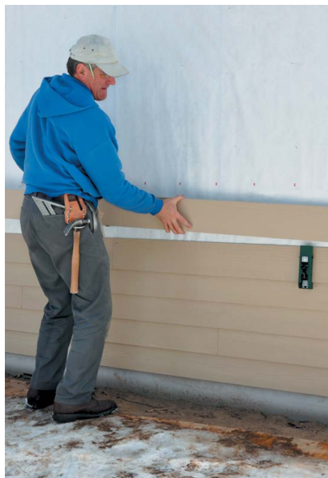
Рис. 43. Установка очередных ламелей
