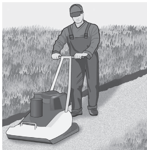
Рис. 3.8. Уплотнение песка с помощью вибротрамбовочной машины
