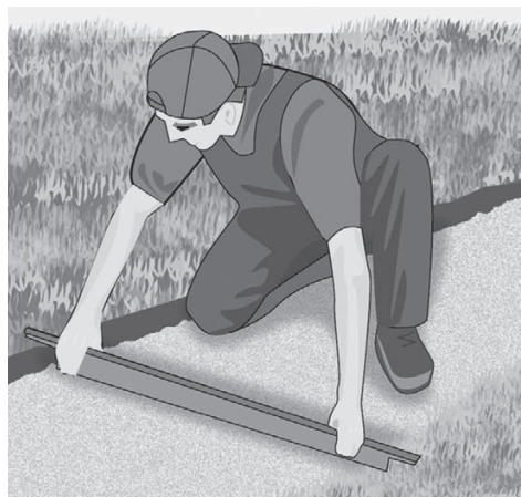
Рис. 3.9. Выравнивание песка рейкой
