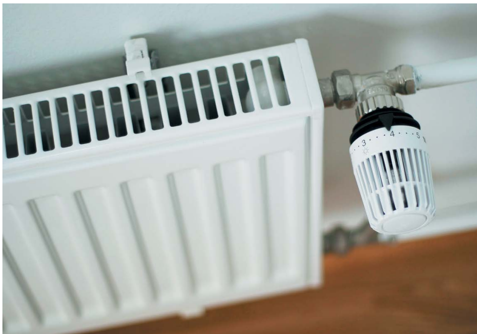
Рис. 39. Стальной панельный радиатор
