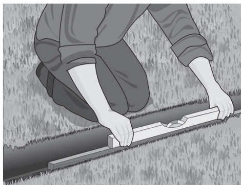
Рис. 2.5. Проверка траншеи под дренаж уровнем
