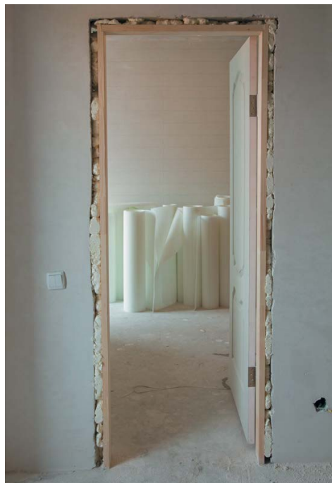
Рис. 25. Заполнение зазоров монтажной пеной
