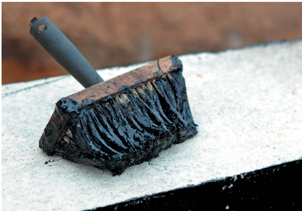
Рис. 8. Обмазочная гидроизоляция фундамента
