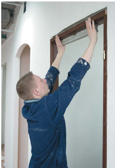
Рис. 24. Проверка вертикальности дверной коробки
