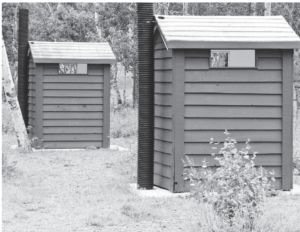
Рис. 7.19. Сухой туалет. Устанавливается над выгребными ямами. Используются также специальные съемные кассеты. Нечистоты обрабатываются с помощью порошкообразных веществ без воды
