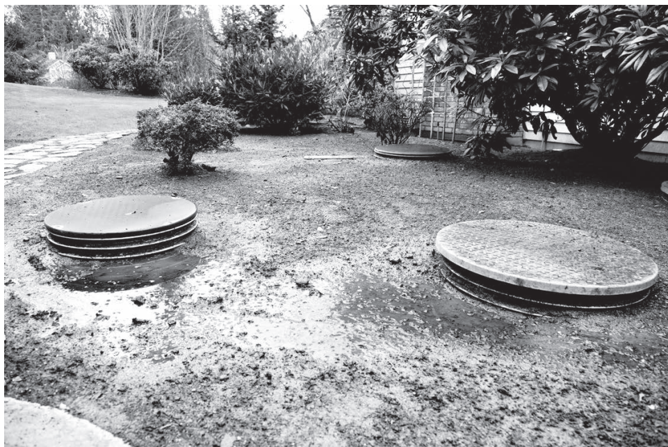
Рис. 7.1. Благоустроенная автономная канализационная система для загородного дома
