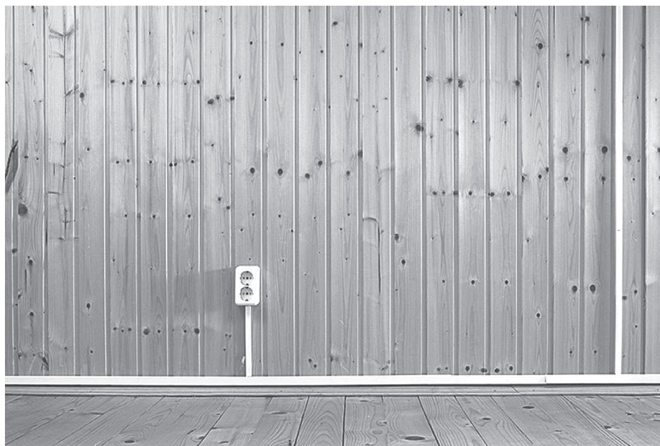
Рис. 1.16. Открытая электропроводка в деревянном доме в пластиковых кабель-каналах поверх деревянной обшивки
