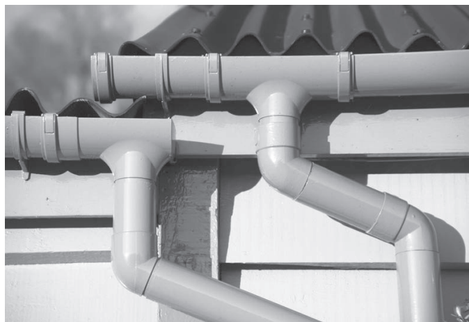
Рис. 8.1. Водосточная труба и желоб
