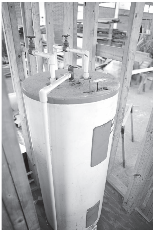
Рис. 11.9. Бойлер — сердце системы отопления с естественной циркуляцией воды
