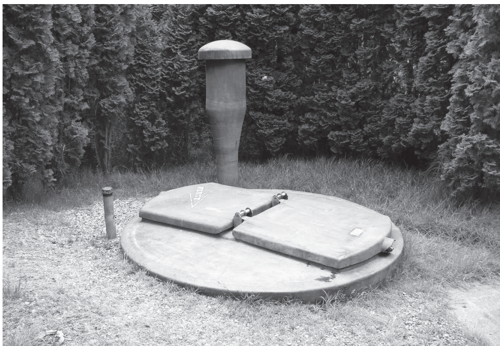
Рис. 8.11. Фильтрующий колодец
