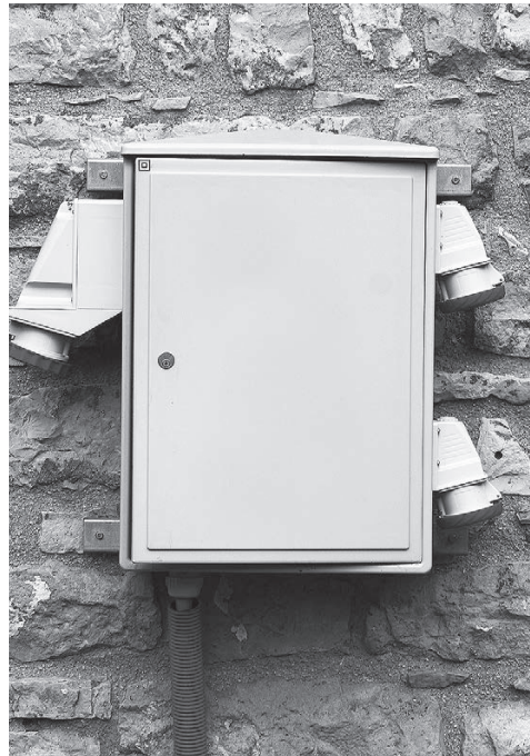
Рис. 1.15. Наружный герметичный щит, на корпусе смонтированы силовые разъемы: слева — трехфазный; справа — однофазные
