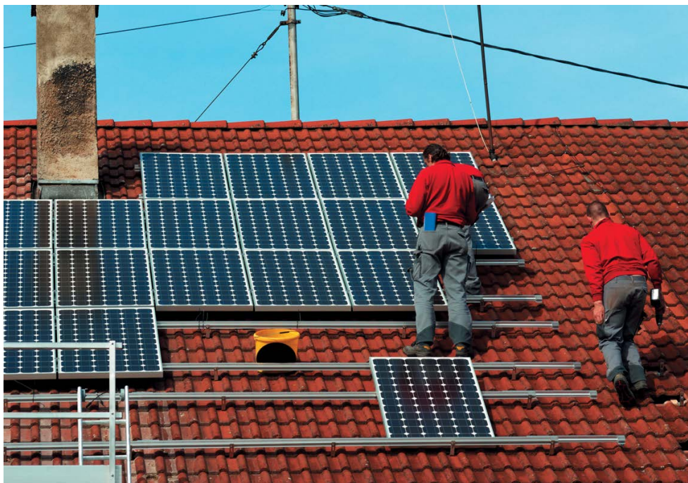
Рис. 5. Монтаж фотозлектрической батареи
