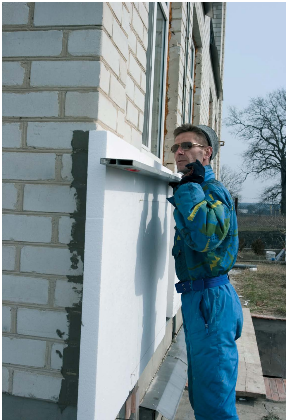
Рис. 14. Наружная обшивка стен дома плитами из пенополиэтилена
