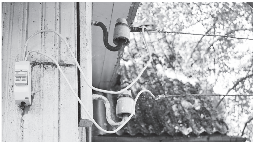
Рис 1.7. Ввод электричества в деревянный дом
