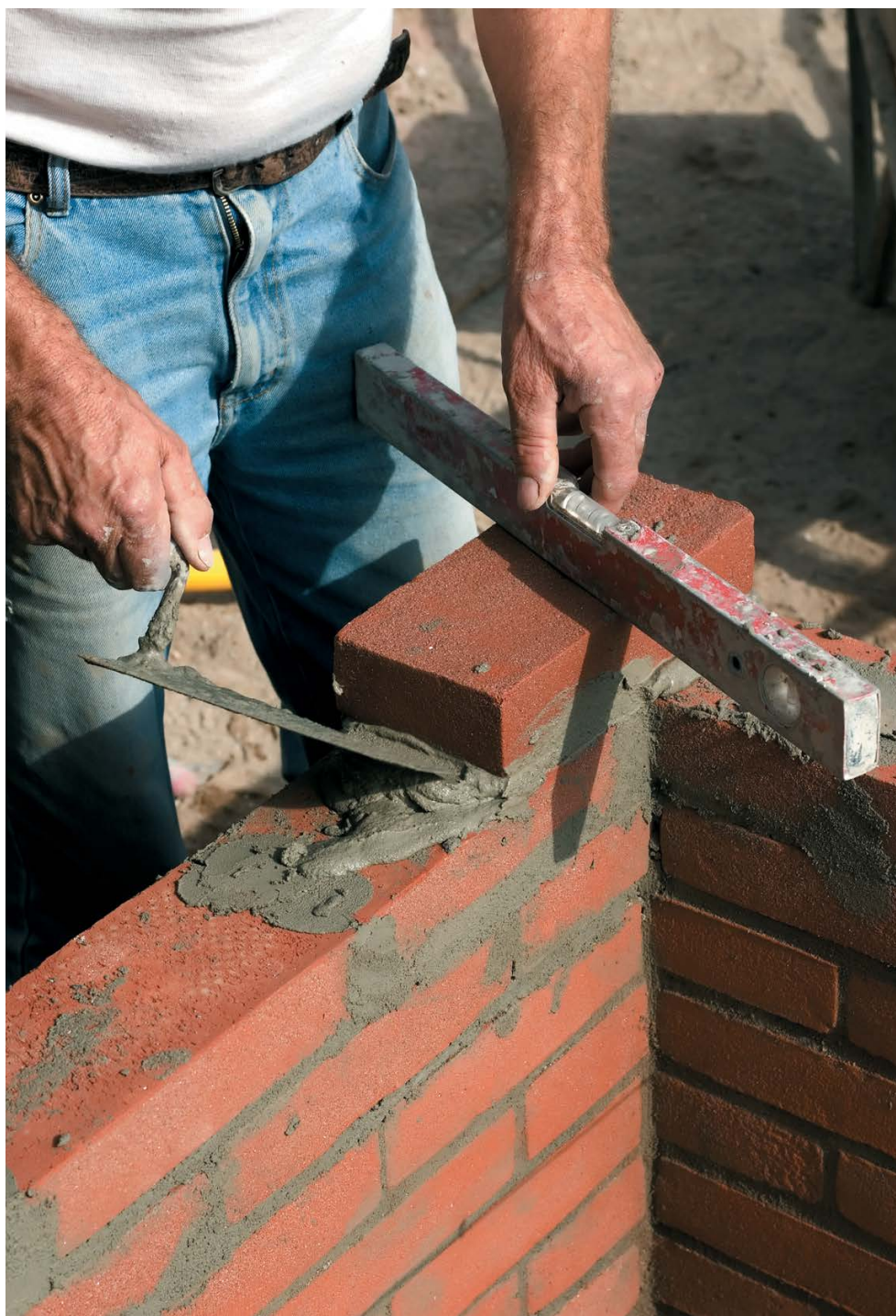
Рис. 17. Нанесение раствора
