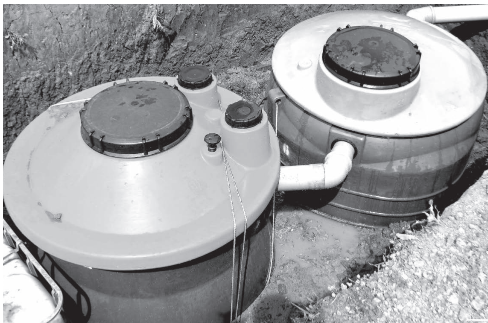
Рис. 8.9. Заводской септик из прочного полиэтилена
