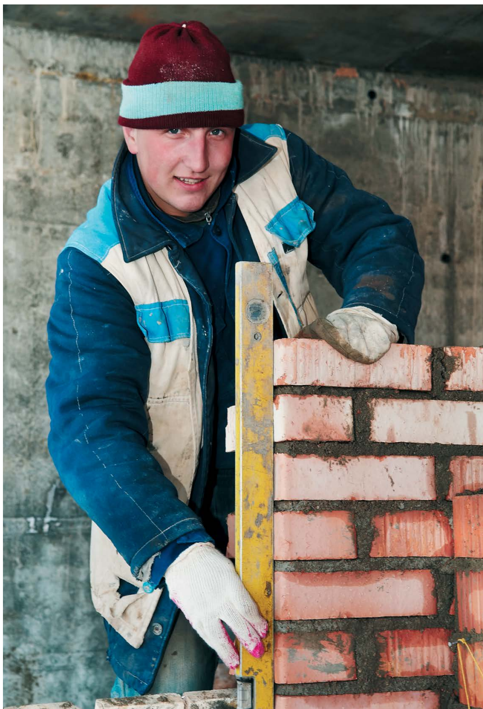
Рис. 18. Контроль кладки уровнем
