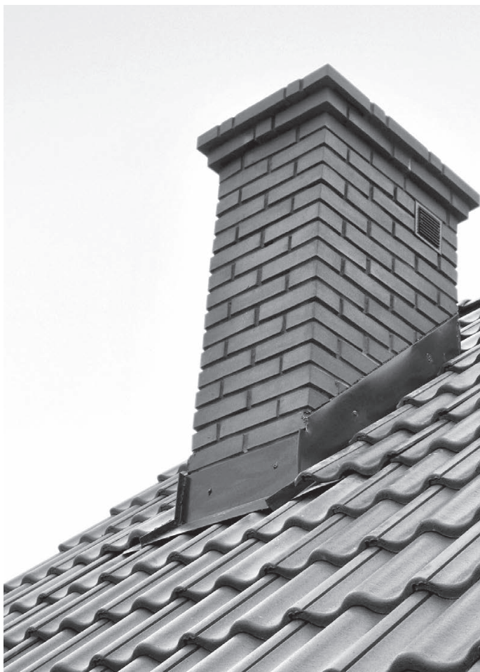
Рис. 10.23. Возведение насадной трубы
