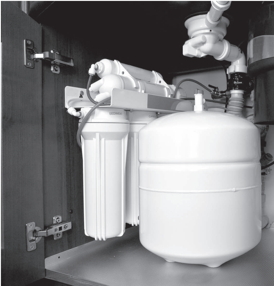
Рис. 3.25. Система фильтрации воды, установленная в доме
