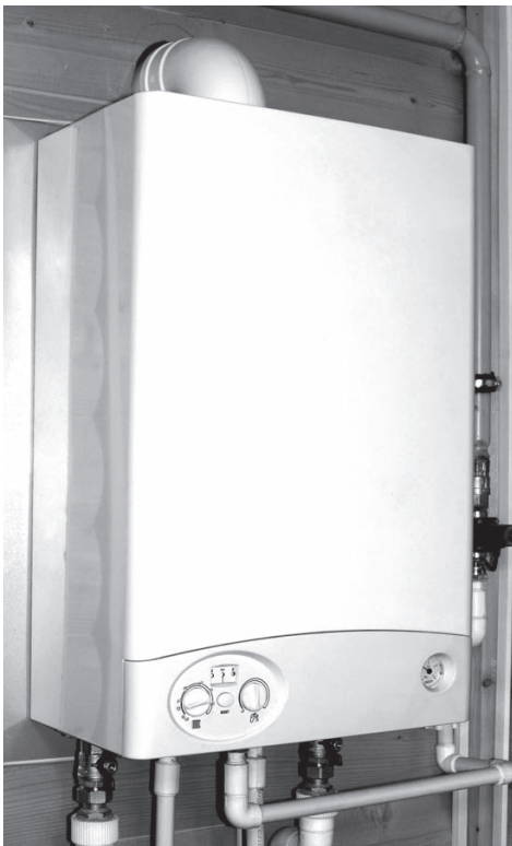
Рис. 6.6. Современная газовая водогрейная колонка
