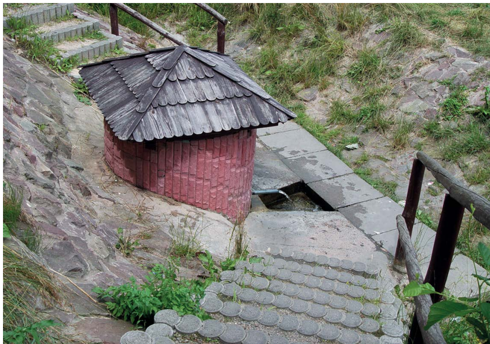
Рис. 8. Обустройство ключевого колодца
