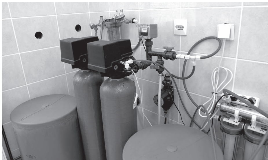
Рис. 3.20. Система многоступенчатой очистки воды
