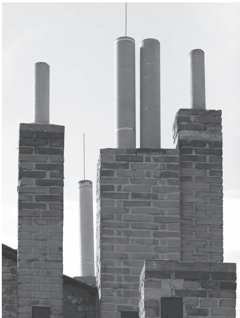
Рис. 10.33. Асбестовые трубы, обложенные кирпичом
