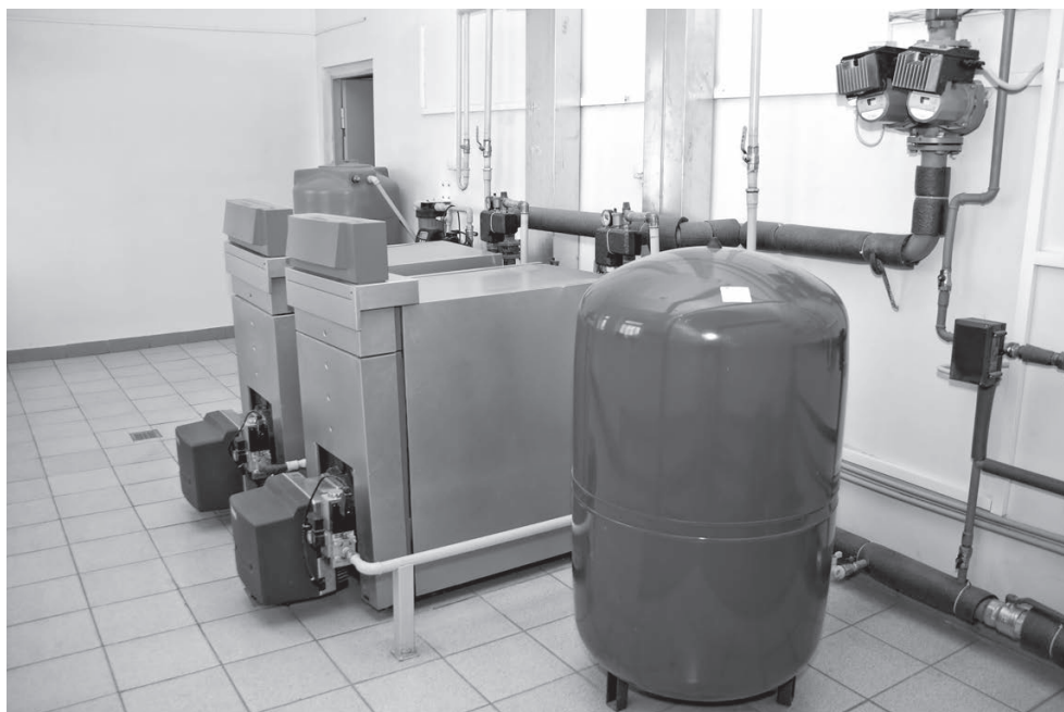
Рис. 11.7. Газовые котлы довольно распространены из-за доступности и дешевизны топлива
