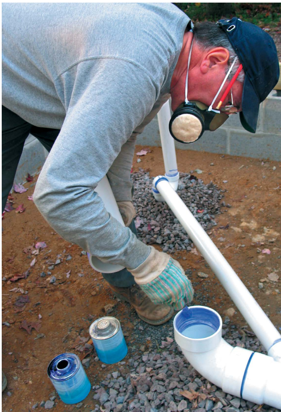
Рис. 11. Монтаж системы трубопровода из поливинилхлорида с помощью клея
