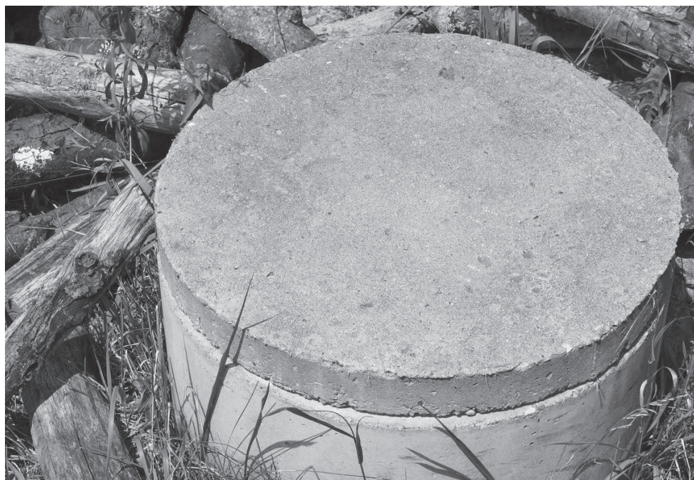
Рис. 8.10. На поверхности размещается только крышка септика
