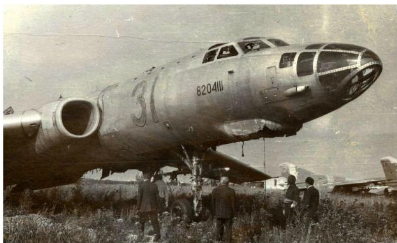
3.18. Бомбардировщик Ту-16 (заводской № 8204111, борт № 31) с многозамковым бомбодержателем под левой консолью крыла на учебном поле Пермского ВАТУ. 1980 г.
