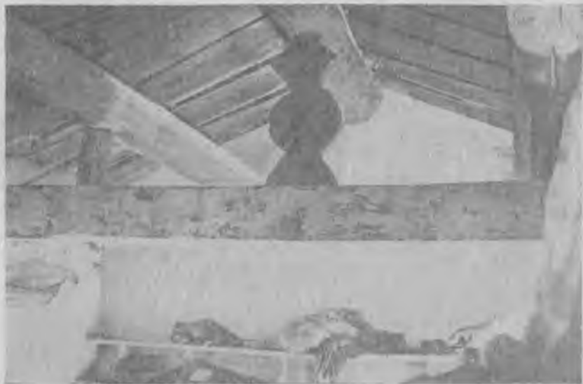
Рис. 23. Конструкция кровли. Маймулы.
