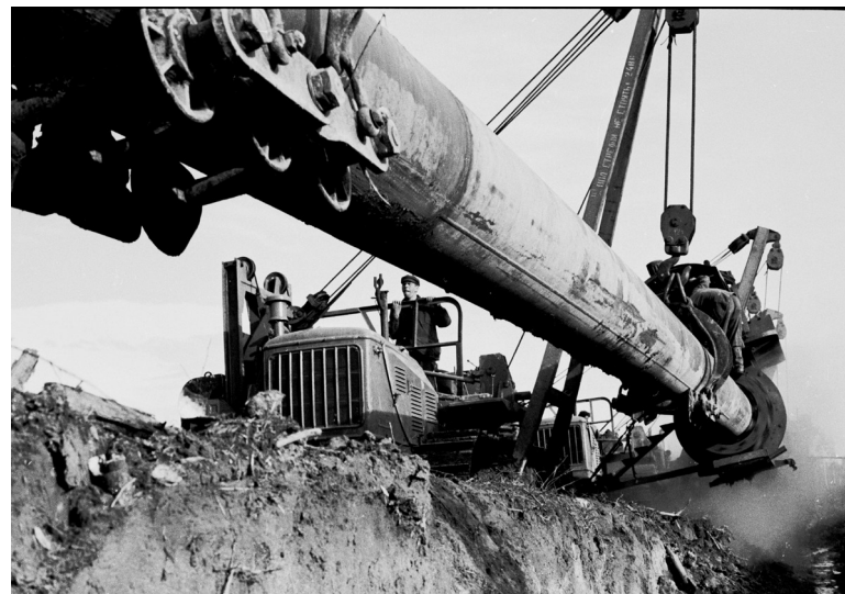
Закладка газопровода Лысьва – Пермь
