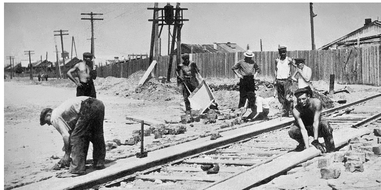
Устройство переезда на участке строительства дороги Пермь – Соликамск. 1960 г.
