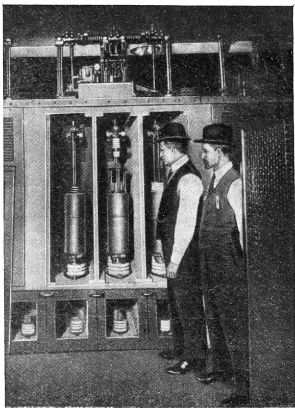
Первые типы масляных выключателей (для электростанций в Чикаго)
