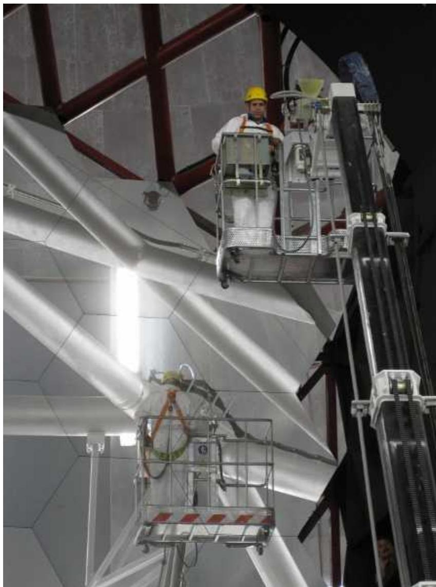
*Рисунок 15: Зеркало Большого канарского телескопа во время чистки. Видны шестиугольные сегменты зеркала. (с сайта <http://www.gtc.iac.es/en/pages/observing-with-gtc/data-commissioning.php>)*
