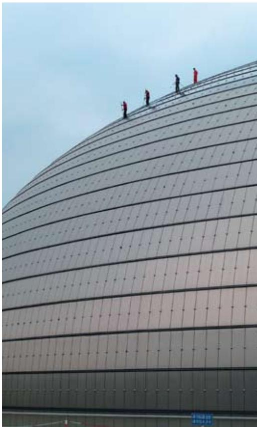
Фрагмент титанового покрытия
