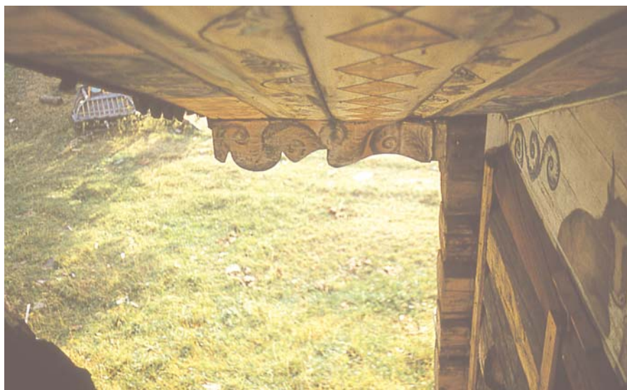
Рис. 58г. Подшивка свеса кровли с росписями главного фасада дома И.В. Горбунова. Село Пакшеньга, Вельский р-н. Фото Н. Бровченко, 1975
