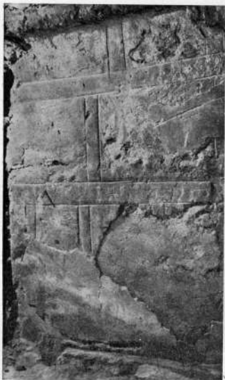
Софийский собор в Новгороде. Внутренняя поверхность кладки восточной притолоки прохода из центральной абсиды в диаконник. Видна разделка стены (проба), сделанная в процессе строительства. Расчерчивание стены на квадраты напоминает южнорусскую систему «opus mixtum» XI века
