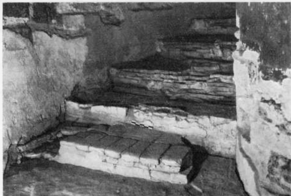
Дополнительная ступень верхнего марша лестницы, сложенная в XVII—XVIII веках из кирпича на известково-песчаном растворе.
