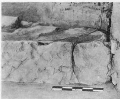
Деталь примыкания подступенка четырнадцатой ступени к круглому столбу башни.
