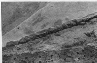
Образовавшийся зазор (щель) между конструктивной кладкой четырнадцатой ступени и пятой мозаичного подступенка.
