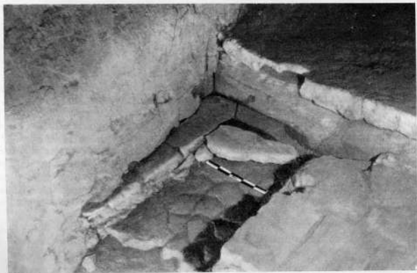
Деталь покрытия первой лестничной площадки керамическими поливными плитами, обнаруженными под дополнительной ступенькой XVII—XVIII веков.
