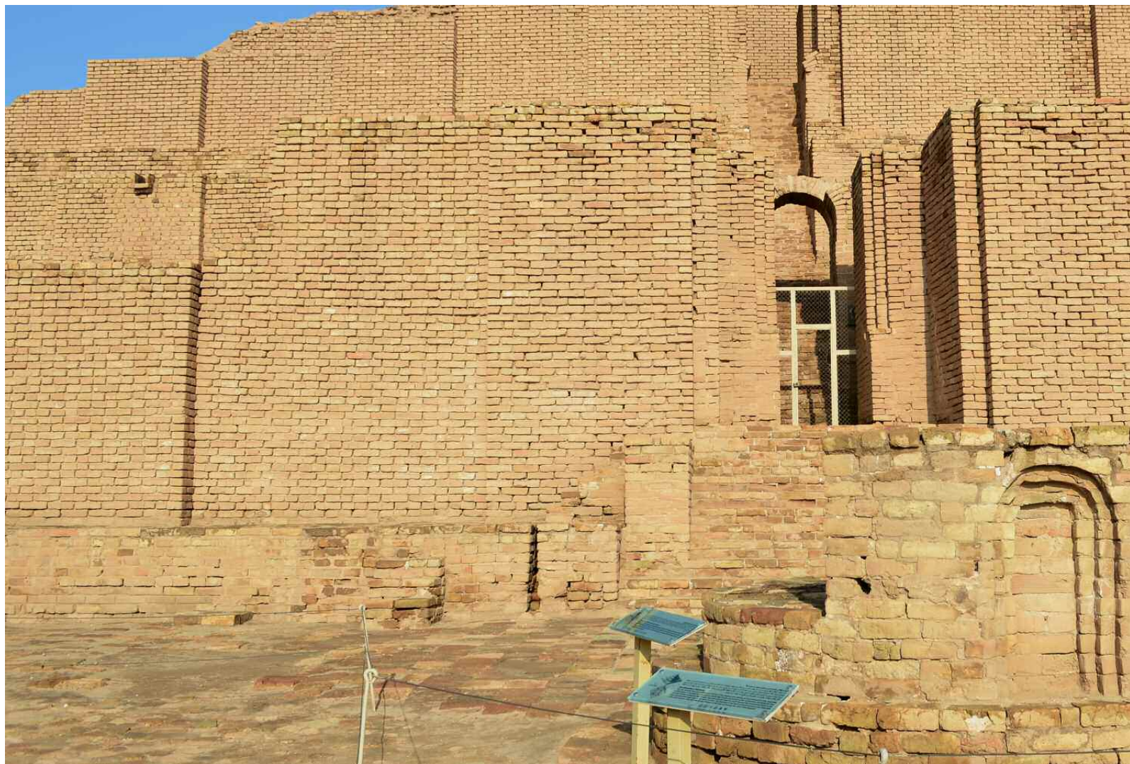
2.1.6. Водослив в виде кирпичного лотка (на снимке слева вверху). Дур-Унташ, юго-западный вход. Реконструкция. Фото: Darafsh, 2014
