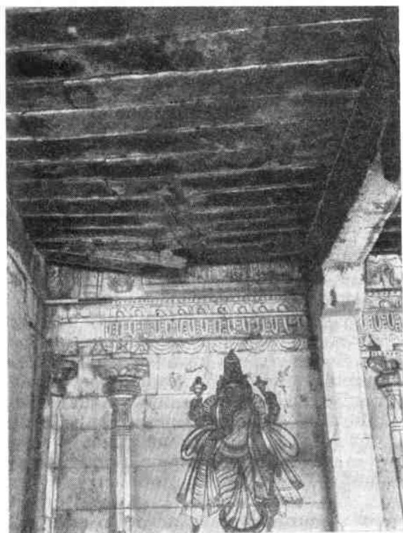
6. Дарасурам. Каменный потолок храма, уложенный наподобие деревянного, XI в.
