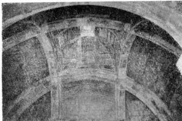
65. Ахпат. Гавит церкви Ншана, перестроен в 1209 г. Перекрытие центральной секции
