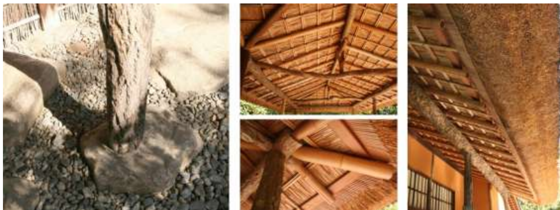
Рис. 151. Фрагменты конструктивных приемов (слева направо): камни-фундаменты опор, конструктивные узлы крыши официального входа в комплекс, вид на срез соломенной крыши павильона ожидания аудиенции.
