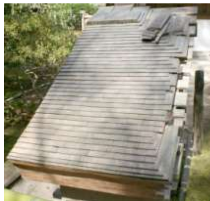
Рис. 144. Макет покрытия Серебряного павильона из пластин японского кипариса размером 30х3 см на бамбуковой основе
