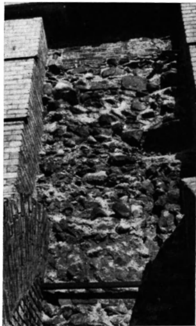
Рис. 56. Золотые ворота в Киеве. Кладка западной стены, укрепленная контрфорсами
