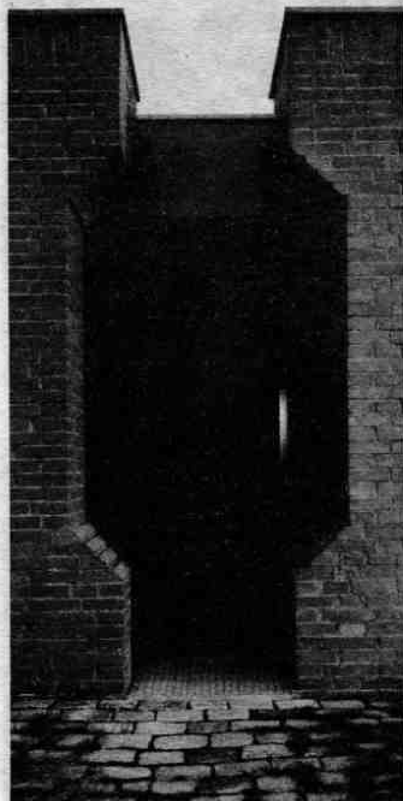
б. Вход в дом с выступами, выложенными из кирпича. Зауживание проема архитектор оправдывал тем, что у въезда в ворота ставятся защитные тумбы. Архит. Зай, Ноймюнстер
