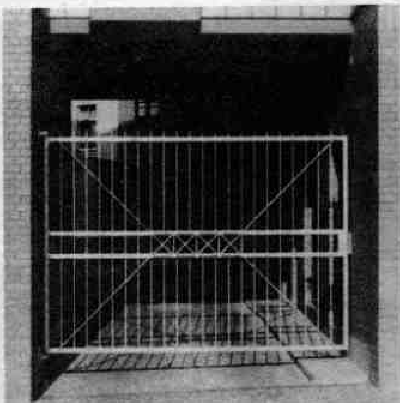
с+d. Въездные ворота с элементами жесткости, образующими плоский орнамент решетчатой системы. Лейбницхаус, Ганновер
