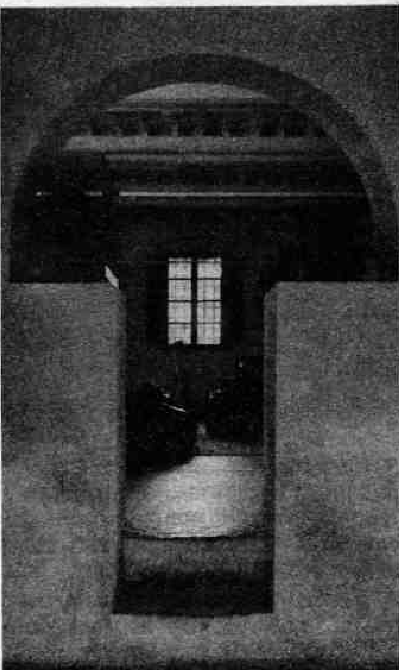
а. Арка с выступами стены, образующая проход между двумя пространствами с различной высотой пола. Выступы стены служат опорами для кружал арки. Дом "Vera Munro"
