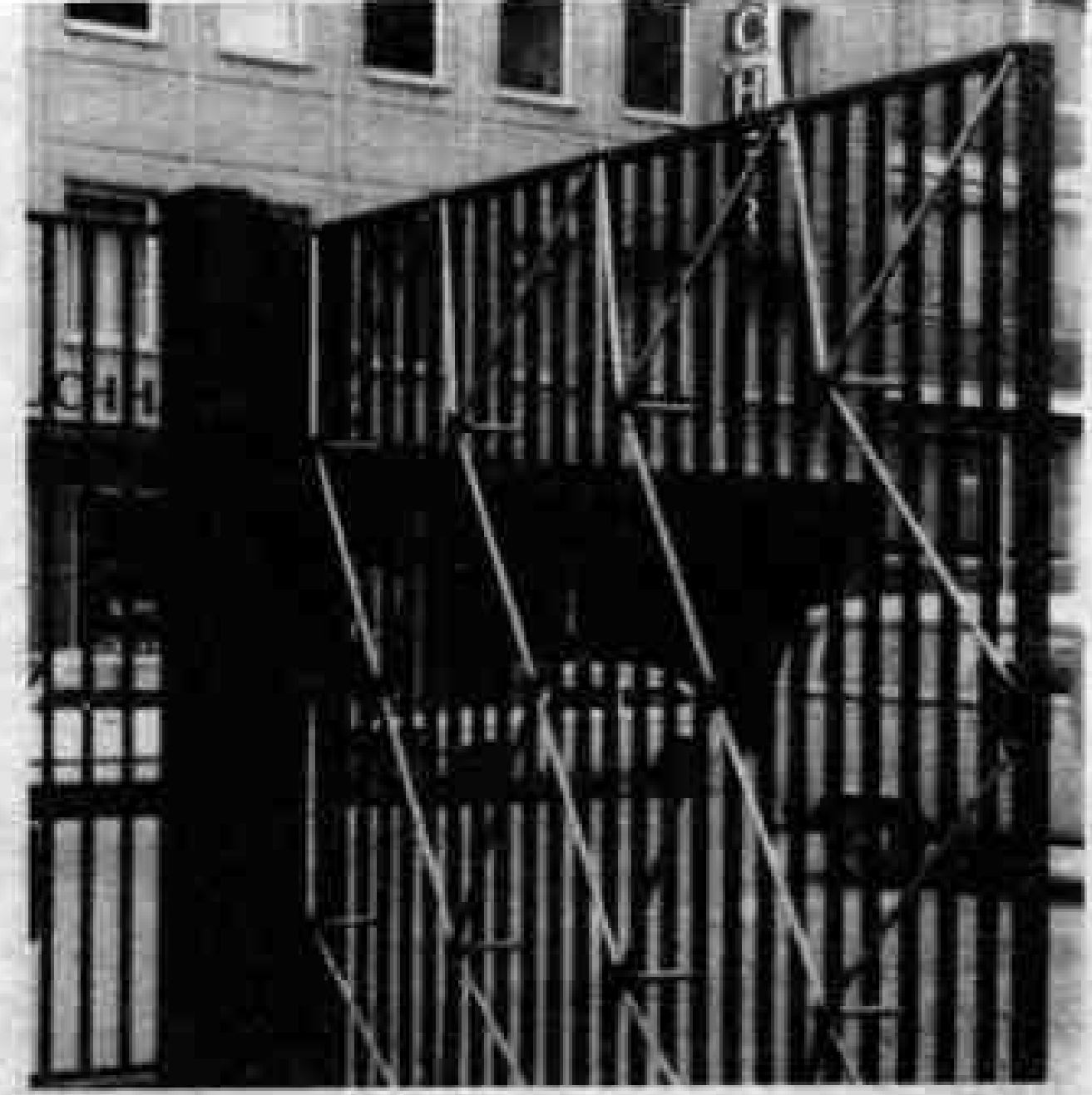
е. Ворота с пространственной раскосной конструкцией в Ганновере. Резиденция земельного правительства
