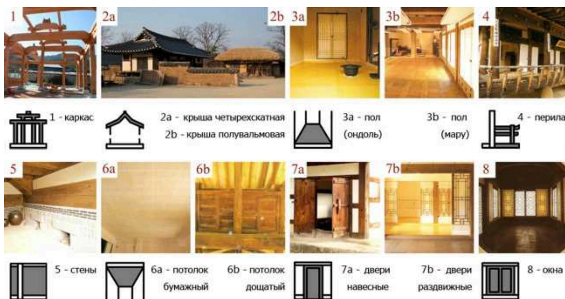
Рис. 90. Основные конструктивно-технологические элементы жилища
