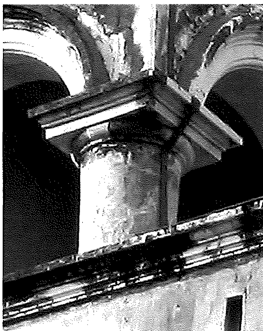
Рис. 3.17. Пример укрупнения абаки дорического ордера в деревне Цзыли (фото 2007 г.)
