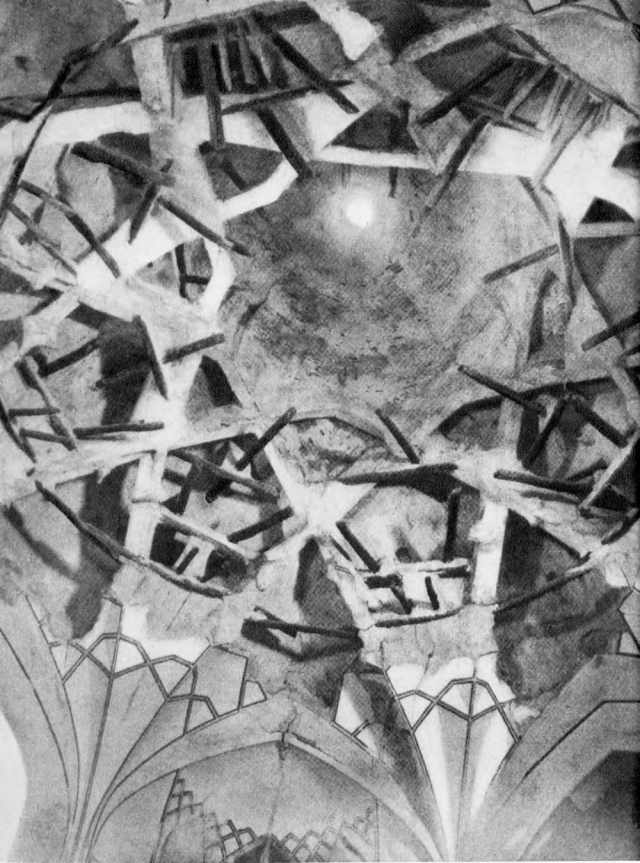
54 Бухара. Ансамбль Бехауддин. Ханака. Конструкция свода. 1544/45 г.
