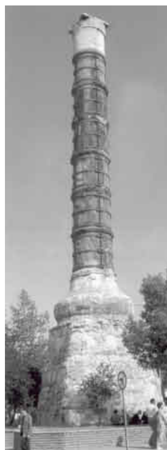
Стамбул. «Янык Сутун» — «Спалённая колонна», якобы стояла на Форуме Константина (4 ст. н. э.). Колонна из порфира, после пожаров усилена железными обручами. Последняя реставрация 1955 года
