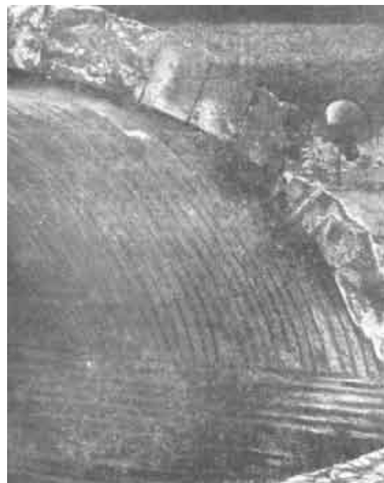
Кирпичный свод над цистерной, расположенной на склоне Акрополя в Афинах (поздний римский период). (Из книги Генри Дж. Коуэна «Мастера строительного искусства»)
