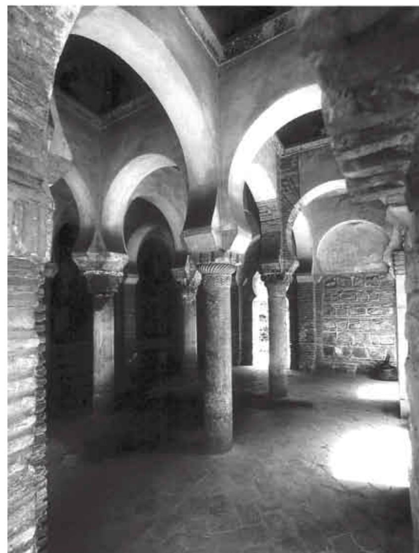
Испания. Толедо. Мечеть Биб Мардун. Видна конструкция перекрытия, поддерживаемая седловидными арками
