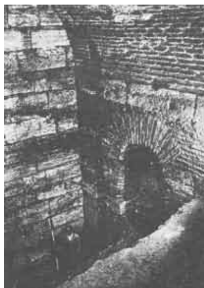
Константинополь, кирпичные своды в подземной части Большого дворца; около VI в.;
