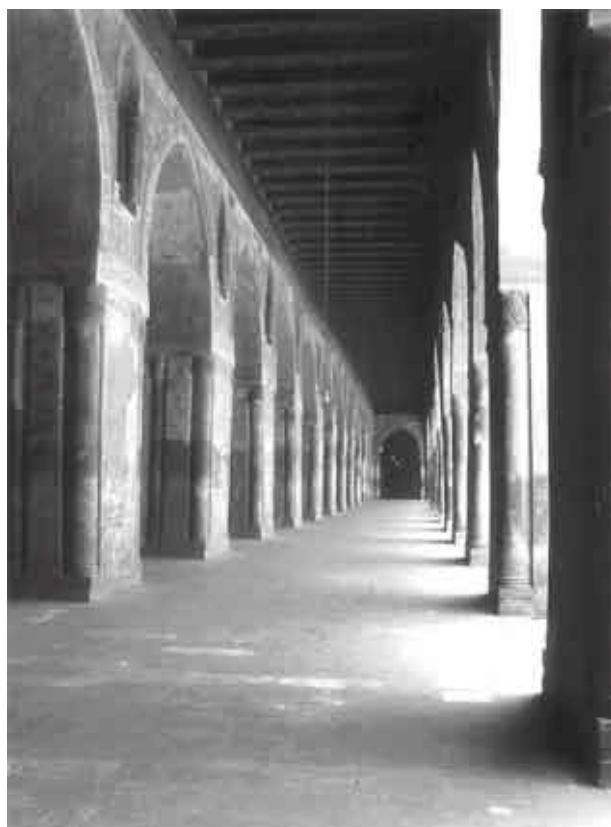
Аркада, поддерживающая деревянную конструкцию потолка — Большая Мечеть ибн Тулун
