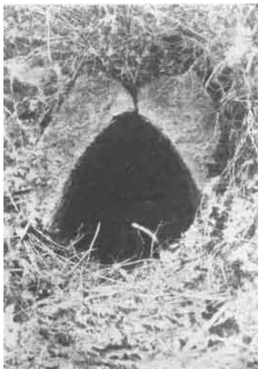
Каменное покрытие канала Древне-Аниенского акведука ложным сводом (272 г. до н. э.)
