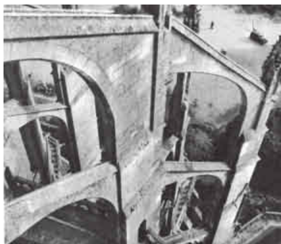
Собор, Реймс, Франция, 1211 г.; аркбутаны, контрфорсы
