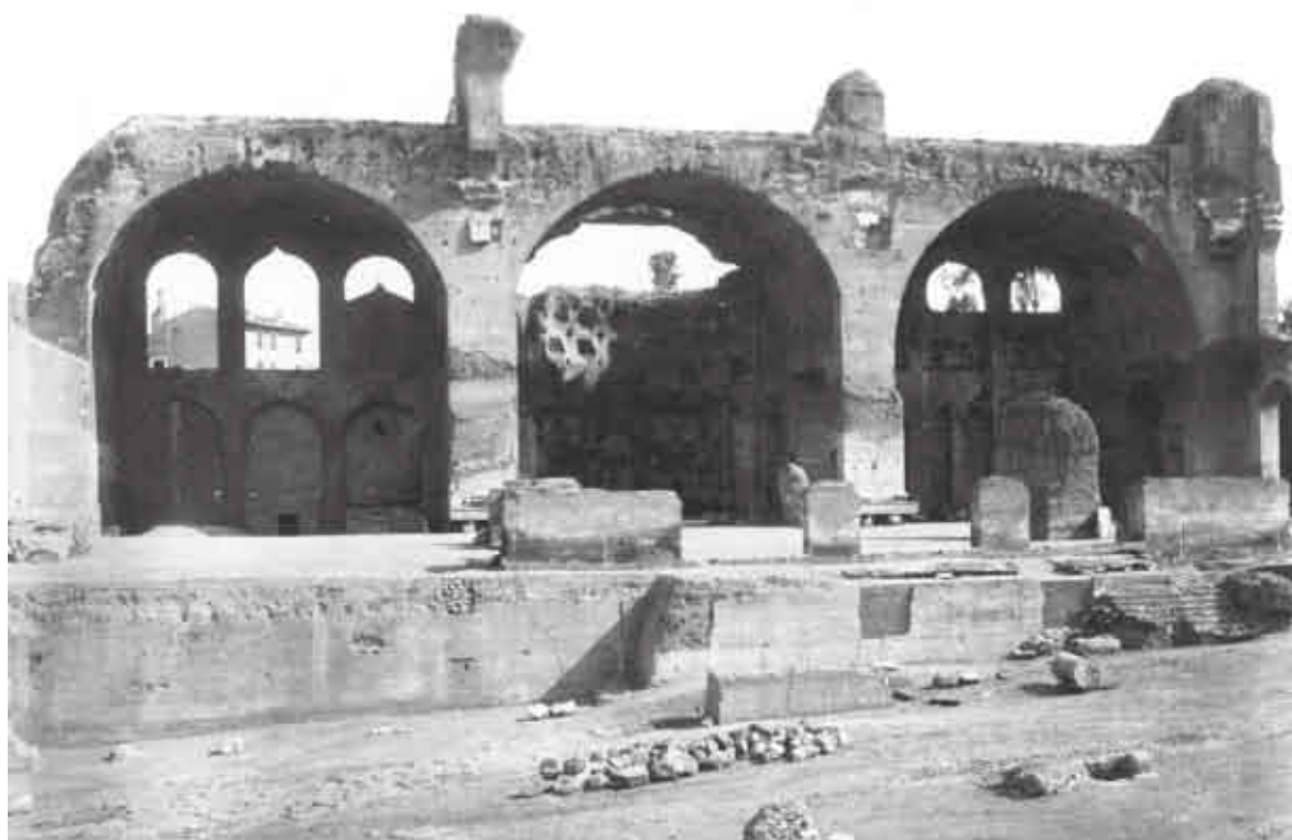
Рим. Базилика Константина (первоначально — Максенция), 3 — 4 век н. э. Пологие арки значительного пролета, техника кладки сводов говорит о византийском влиянии. Затем мы видим эти приемы в Западной Европе в Средние века. Фото конца XIX в.
