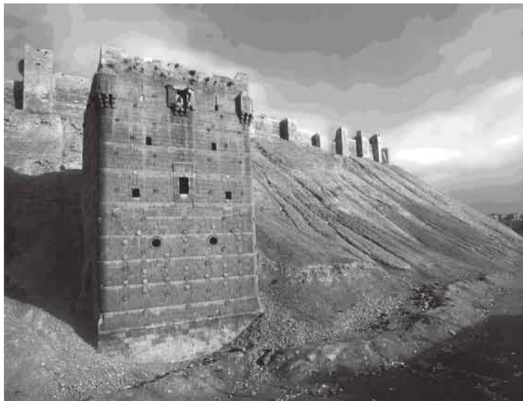
Цитадель в Алеппо: башни, стены и гласисы (передний скат бруствера). Построена в XIII в. Каземат достроен в XV в.
