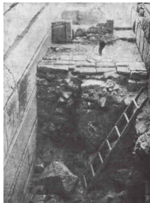
«Опус квадратум» — квадратные каменные блоки из храма в Иерусалиме, построенного царем Иродом в 34 г. до н. э. (Из книги Генри Дж. Коуэна «Мастера строительного искусства»)
