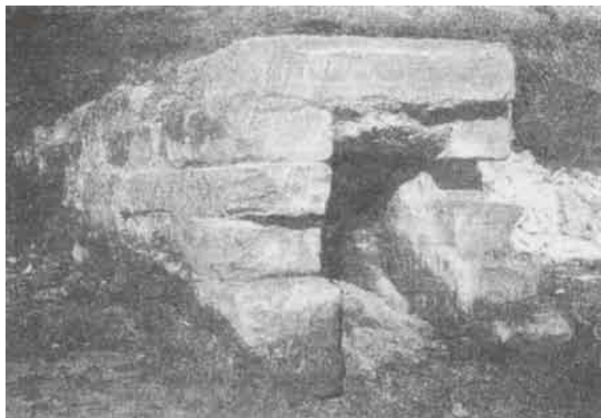
Аниенский акведук. Прямоугольный канал с покрытием платой
