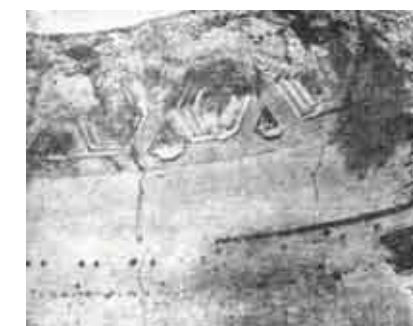
Трещины в бетонной кладке полукупола в термах Траяна в Риме. Видный на снимке арматурный стержень — элемент недавнего усиления
