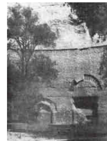
Ряды кирпича, служившего облицовкой и постоянной опалубкой бетонных стен терм Траяна
