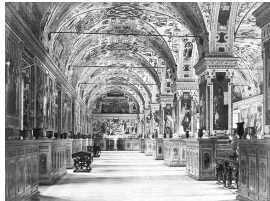
Рим. Интерьер зала библиотеки в Ватикане. Основана в 1475 г., здание построено в XVI в. для Сикста V архитектором Доменико Фонтана. Хорошо видны металлические затяжки, воспринимающие распор. Фото конца XIX в. В одном из залов находятся «античные» фрески, обнаруженные в 1607 г. (!) — часть фриз, который отнесли к первым годам Августа («Альдобрандийская свадьба»)
