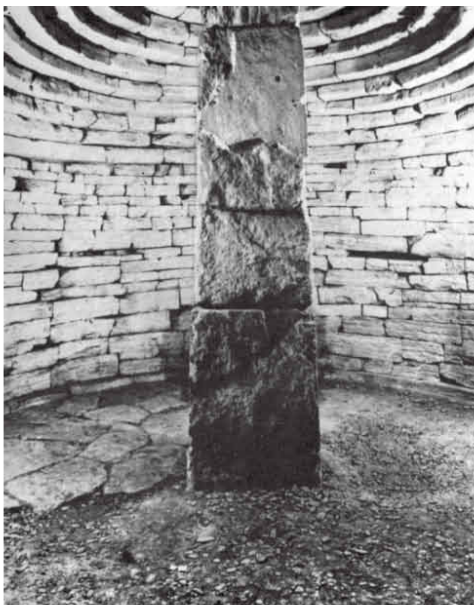
Гробница в Казале Мариттимо (Вольтерра). Конец VII — начало VI в. до н.э. Хорошо виден ложно- опорный столб, характерный даже для жилищ строительных рабочих эпохи Рамзеса Великого
