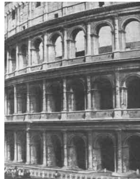
Амфитеатр Флавиев в Риме, широко известный под названием «Колизей» (70 — 82 гг. н. э.). Самое высокое из сохранившихся сооружений античного Рима. Облицовка фасадов из травертиновых блоков, уложенных без раствора и крепящихся между собой железными скобами. Сооружение в течение многих веков использовалось как каменоломня
