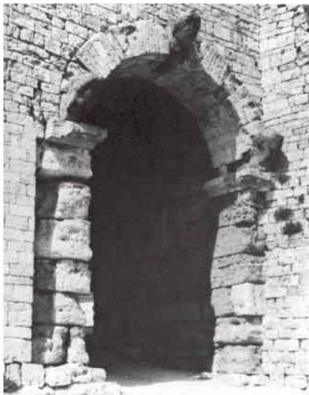
Ворота в этруском городе Вольтерра: сводчатая конструкция, замковый камень и пяты арок были украшены изваяниями голов. III в. до н.э.
