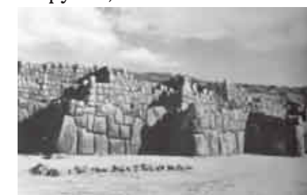
Фортификационные сооружения в Саксайхуаман, Куско, Перу, 1400 г. н. э.(?), циклопическая безрастворная кладка
