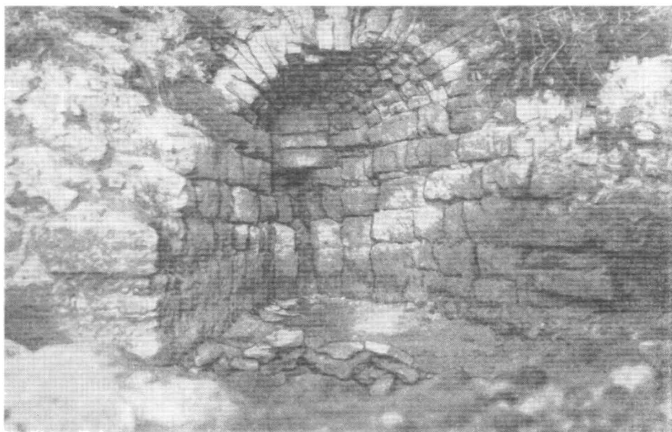
Рис. 106. Бойница первого яруса юго-западной башни. Вид изнутри.
