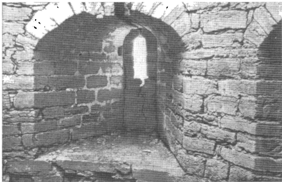
Рис. 77. Типовая огнестрельная бойница Копорья начала XVI в. Вид изнутри (второй ярус, южная башня).
