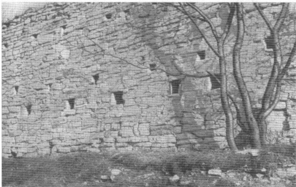
Рис. 146. Гнезда балок раската в стене Псковского захаба.
