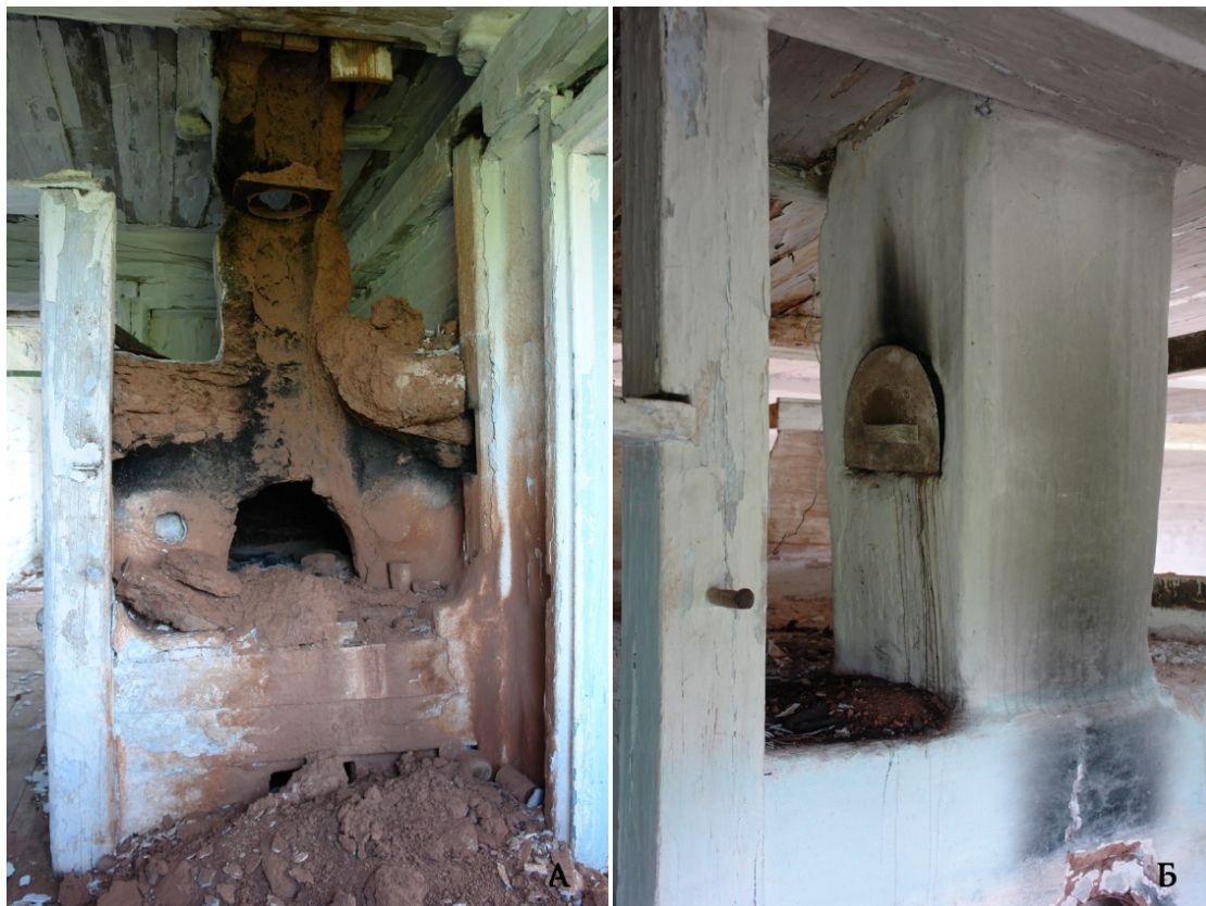
Рис. 2. Место нахождения вьюшки в конструкции печи.
