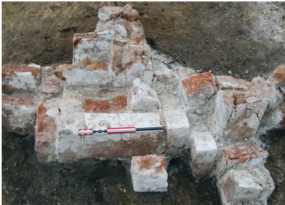
Рис. 8. Фрагмент башни, упавший в лощину-всход. Хорошо видна коробка из четырех кирпичей, заполненная двумя половинками кирпичей
