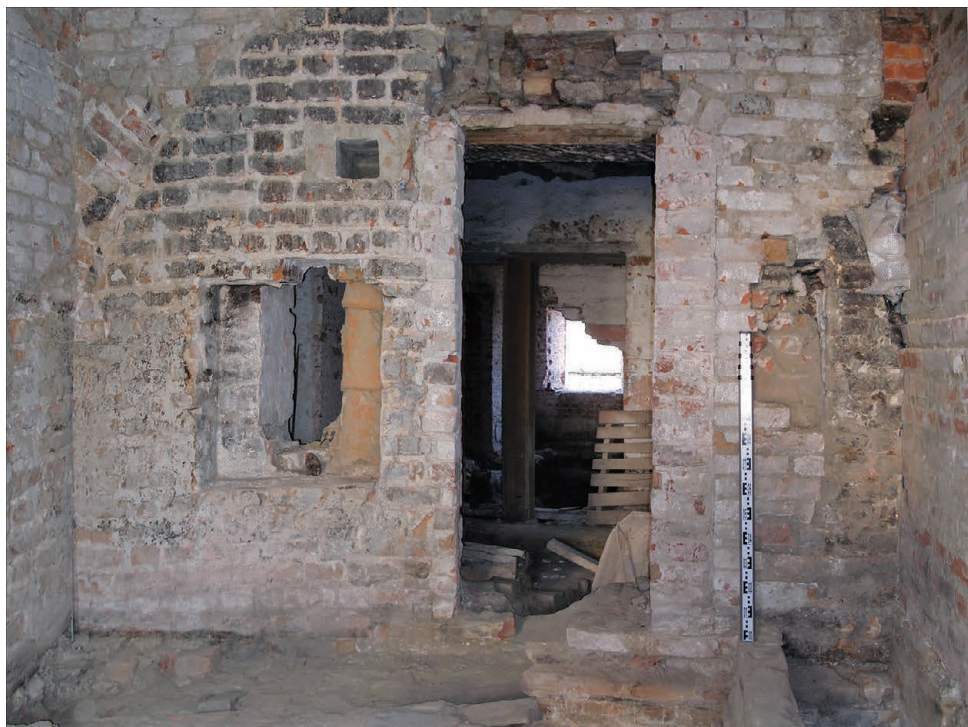
Рис. 3. Соловецкий монастырь, Святительский корпус. Южная стена помещения больничной палаты с калориферным отоплением. Перестроена в 1847 г. из передней братской кельи № 49 начала XVII в. Вид с севера на раскрытое архитектором-реставратором В.В. Сошиным (ООО «Палата») древнее окно и внутристенный вертикальный канал, сложенный из красноглиняных труб. Гретье́й воздух подавался в помеще́ние через специальное верхнее отверстие-душник в стене. Фото В.А. Бу́рова. 18 июня 2011 г. Компьютерная склейка панорамы Н.Н. Скворцова
