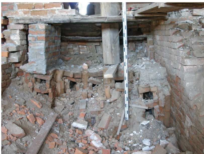
Рис. 1. Остатки калориферной печи воздушного отопления в подвале южного помещения Святительского корпуса напротив бывшей кельи № 49. Обнаружены рабочими ООО «Палата» в мае 2011 г. Глиняные трубы установлены вертикально между пятью горизонтальными каналами, сложенными из кирпича. Фото В.А. Букова. 18 июня 2011 г.
