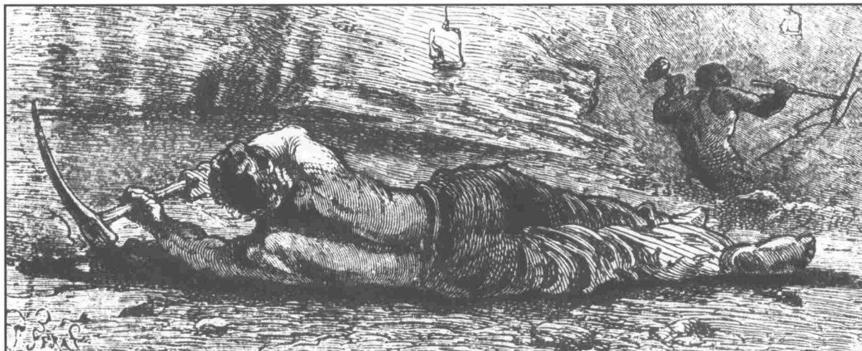
Рис. 14.1. Германия. «Кривошейная» работа по жилам медистых песчаников Мансфельдского месторождения. По работе [Промышленность и техника 1904, с. 191–192, рис. 215]
