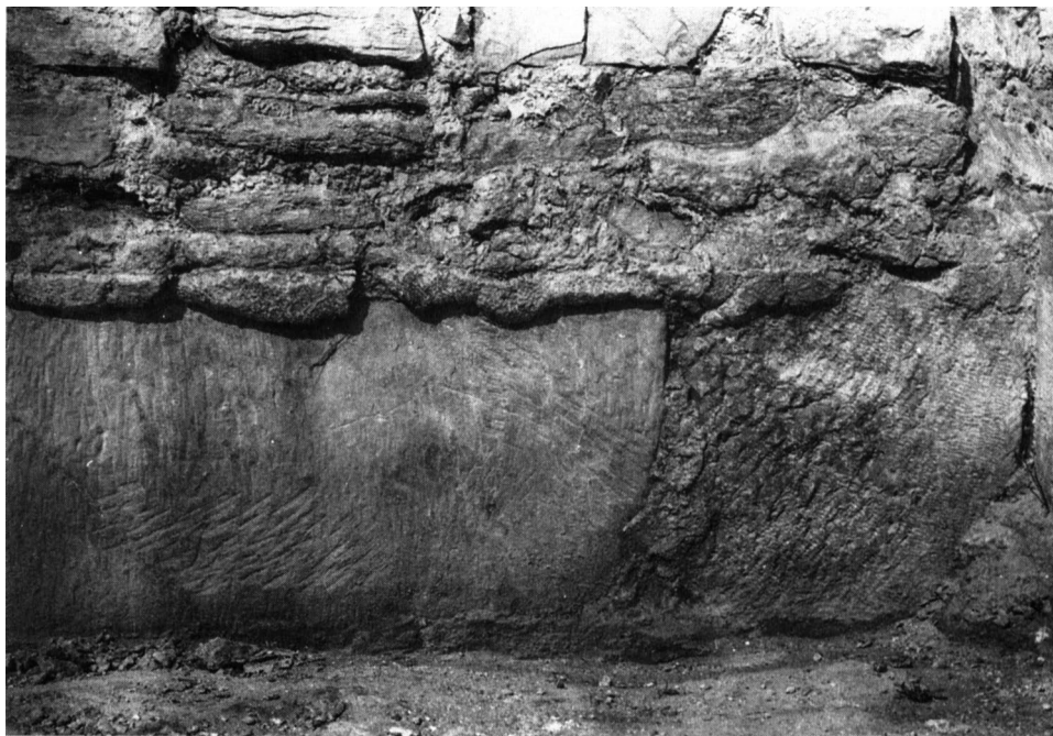
Рис. 156. Следы обработки на камнях цоколя в проезде ворот (западный пилон)
