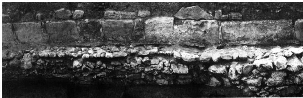
Рис. 164. Восточный пилон. Кладка фундамента и цоколя восточной стены
