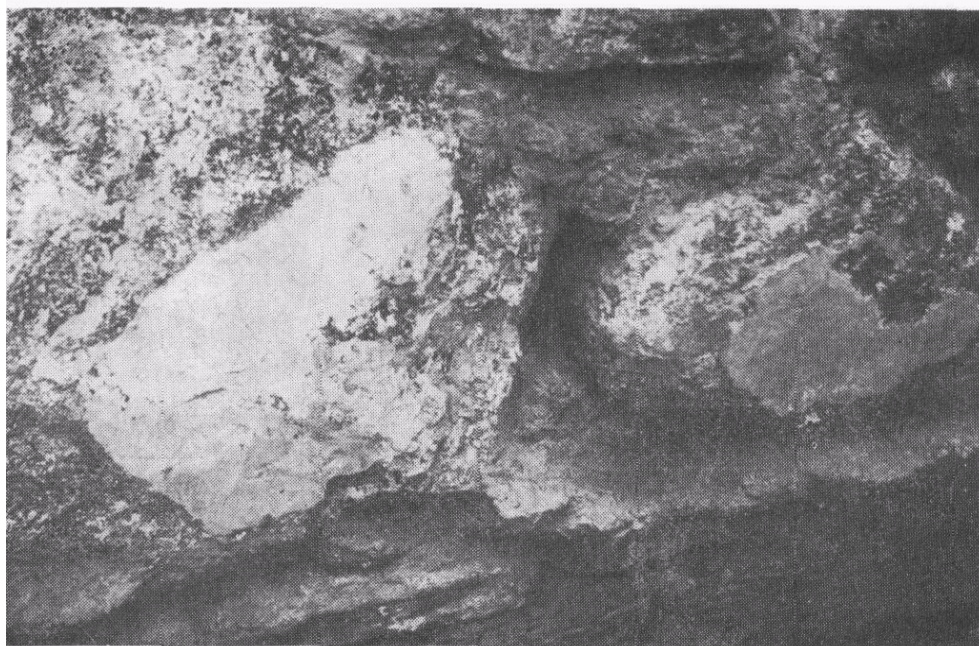
Рис. 5. Бутовый камень вторичного использования с цемяпочной затиркой
