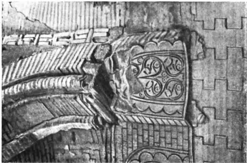
Рис. 12. Правая пята громовой арки, опирающаяся на деревянные брусья
