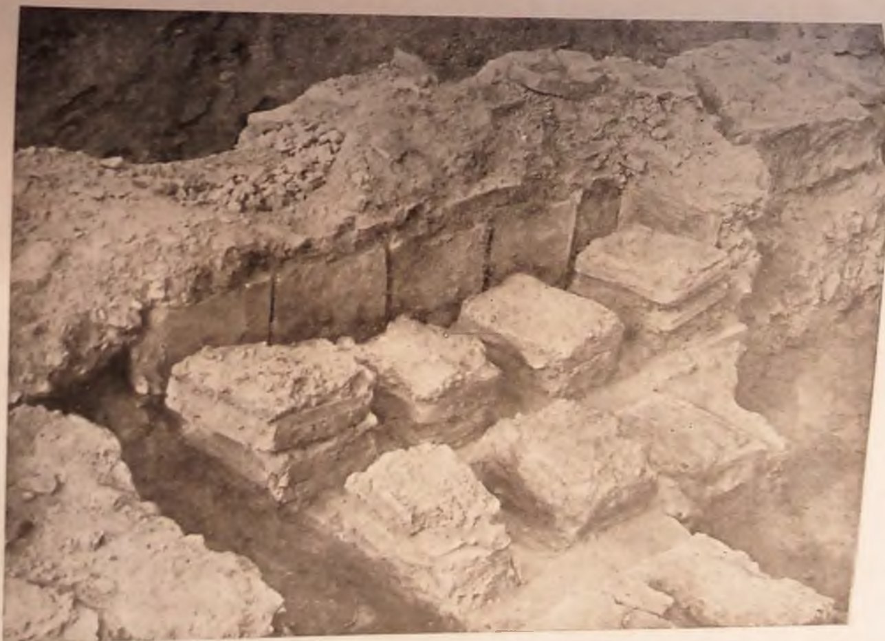
Рис. 181. Софийский заповедник. Печь для обжига кирпича. Деталь.
