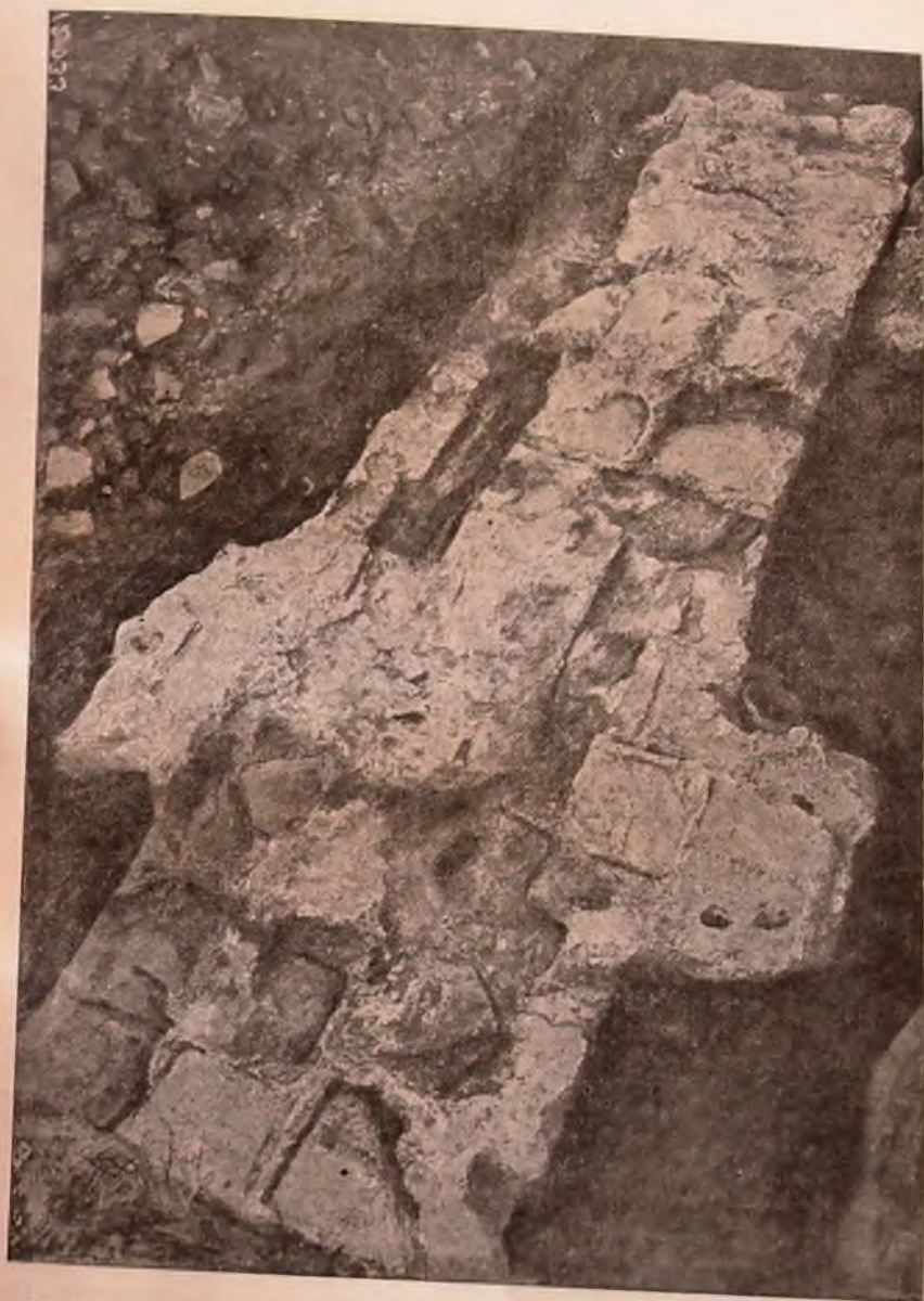
Рис. 48. Десятинная церковь. Следы деревянных связей в кладке фундаментов (раскопки 1939 г.).
