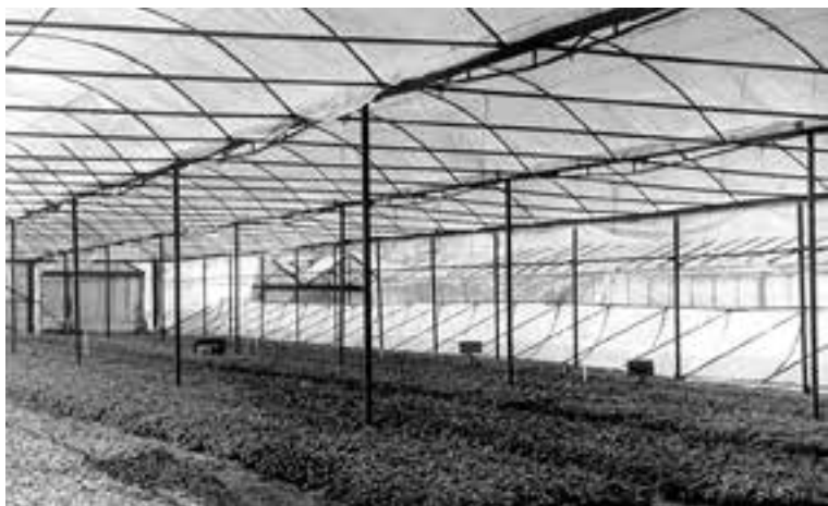
Рис. 10. Трехзвенная блочно-арочная теплица конструкции совхоза «Минская овощная фабрика»
