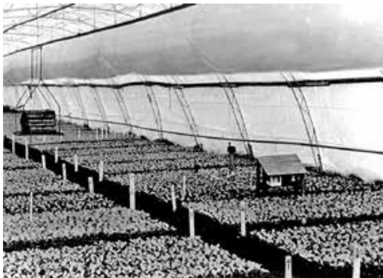
Рис. 16. Распределение теплого воздуха от теплогенератора посредством перфорированного пленочного рукава в рассаживаемой теплице конструкции ЦИМЭЖ
