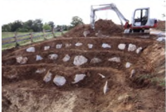
То же самое сооружение (вид на западную сторону): в террасы встроены валуны. В больших пространствах между ними располагаются оптимальные места для произрастания многочисленных трав.
