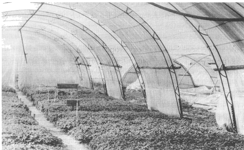
Рис. 7. Общий вид пленочной теплицы конструкции УИМЭЖ при 50 %-ном снятии пленочного покрытия во время закаливания рассады помидора
