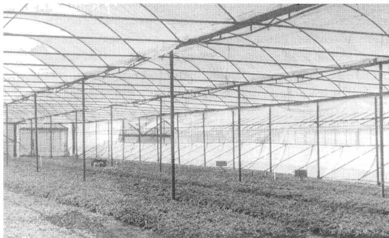
Рис. 8. Трехзвенная блочно-арочная теплица конструкции совхоза «Минская овощная фабрика»
