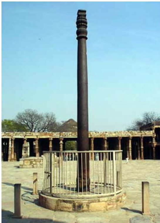
Кутубская колонна в Дели на 99,72% состоит из чистого железа
